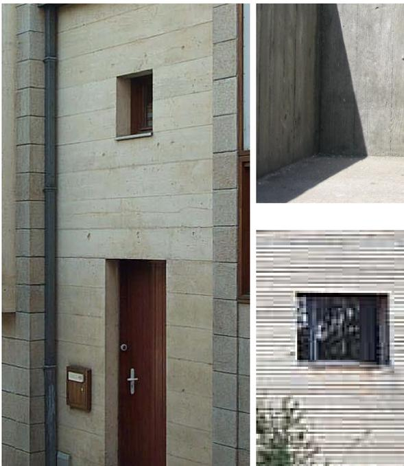
Utilisation de béton banché dans une construction neuve
