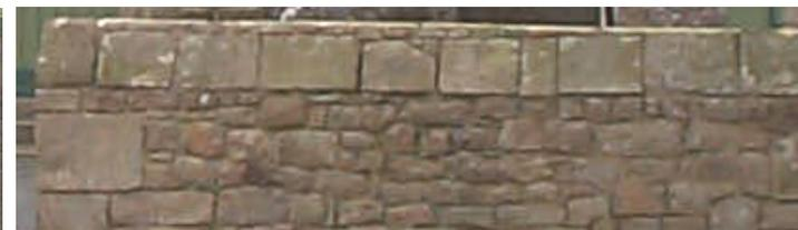
Chaînage d'angle et tête de mur en pierres de taille
