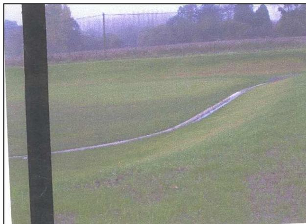
Photo 2 : Bassin paysager avec cunette centrale en béton dont le tracé rappelle celui d'un cours d'eau
